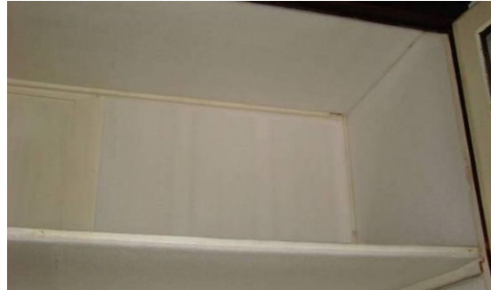
Colocación de protección con espumas
