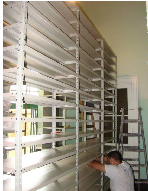
Colocación de estanterías
